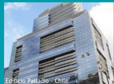
Edificio Palladio - Chile
